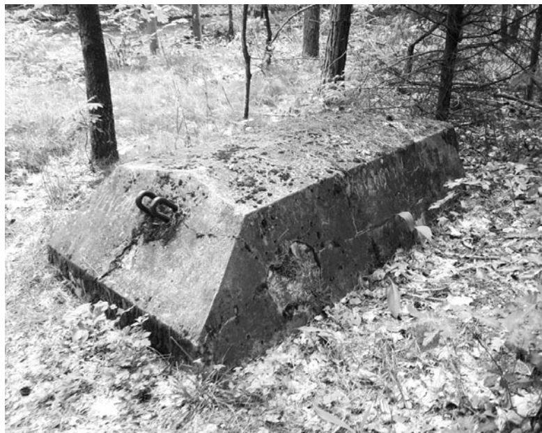
Betonowy odciąg do wieży w pobliżu sanatorium
