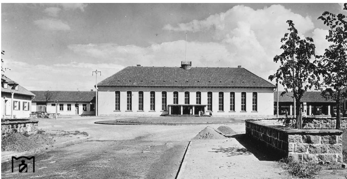
Dworzec kolejowy tuż przed oddaniem do użytkowania
